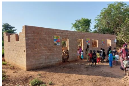
De crèche in aanbouw in Binhai (januari 2025)
