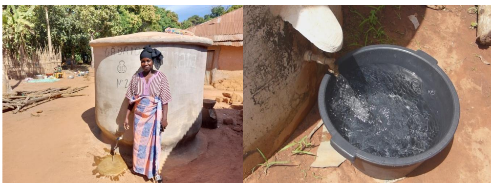
Opvangtank voor regenwater - levert prima kwaliteit drinkwater
