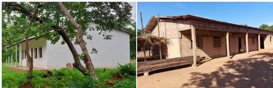
De schoolgebouwen in Madina de baixo (L) en Gantamba (R).
