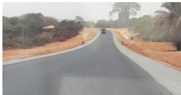
De nieuwe asfaltweg nabij Empada
