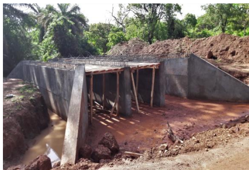
Brug in aanbouw op de weg Buba-Empada
