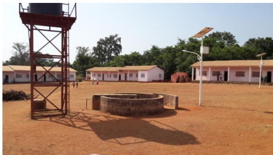
De nu weer fris ogende gebouwen van de openbare basisschool in Empada
