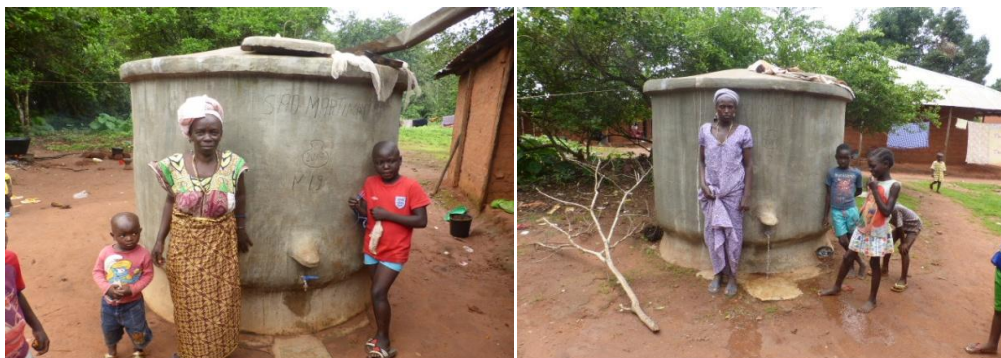
Gebouwde regenwater opvangtanks in Sao Martinho, op 30 km ten westen van Empada.
